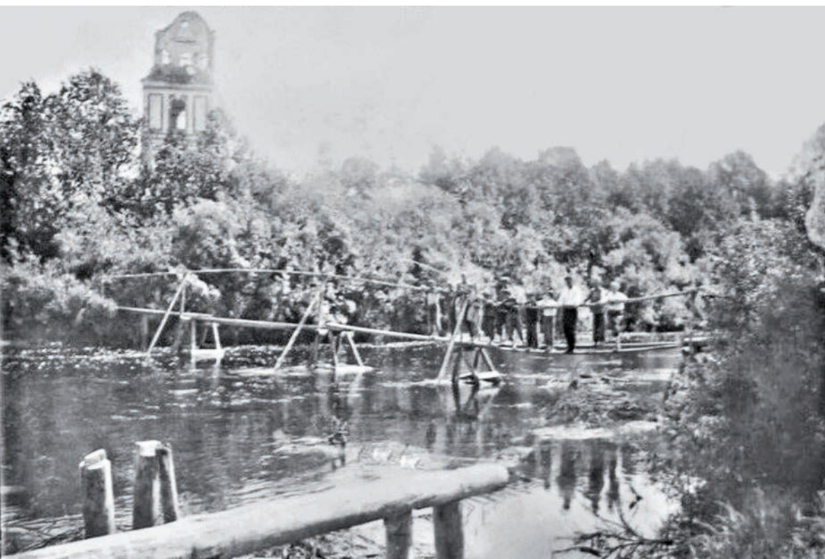
Мостик через р. Ивкину. Нижнеивкино. 1950–1959 гг. Фото Вшивцева А. И. Из открытого источника: https://pastvu.com/p/1000068
