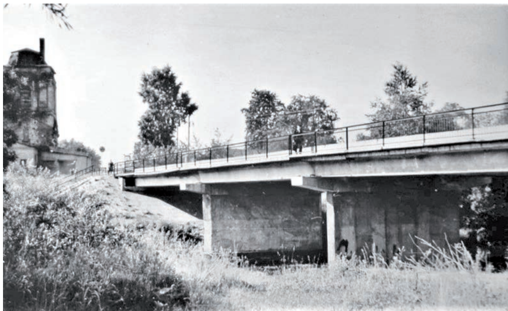
Мост через реку Ивкину. Нижнеивкино. 1983–1985 гг. Фото Вшивцева А. И. Из открытого источника: https://pastvu.com/p/999129
